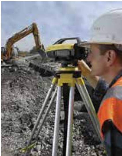
شکل ۱- ۱۴ - اجرای تسطیح و کنترل حین اجرا
