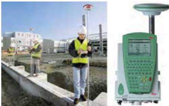
شکل ۷-۶ - پیاده کردن نقاط با GPS و PDA
