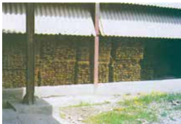
شکل ۲-۱۷- نحوه نصب آفتابگیر در اطراف واحد دسته‌بندی
