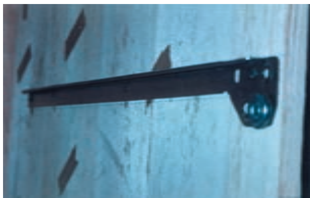
شکل ۳۱- نصب ریل روی بدنه
