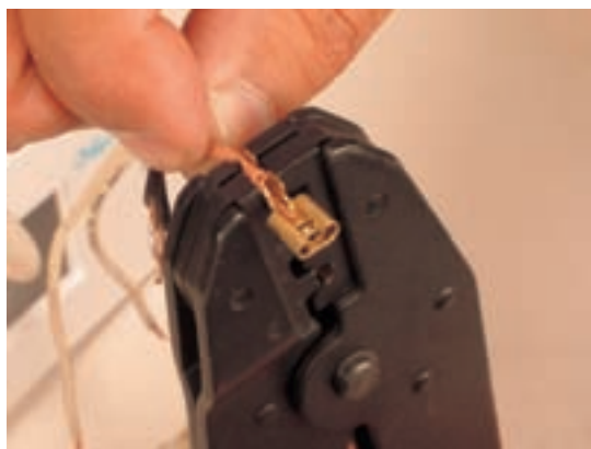
شکل ۲۳-۳- نحوه‌ی پرس کردن سرسیم
