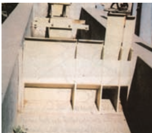
شکل ۹-۷- دریچه نیربیک
