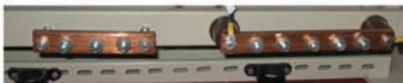
شکل ۱۶-۳ اتصال پیچی
