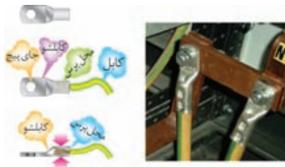
شکل ۳۵-۳ کابل شوی پرس شده
