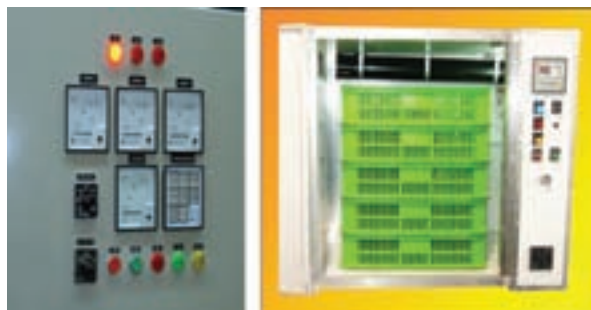
شکل ۴۵-۵ کاربرد لامپ‌های سیگنال در دستگاه جوجه‌کشی و تابلوی برق
