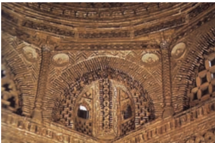
تصویر شماره ۲۳-۳ الف - فضای داخلی مقبره امیر اسماعیل سامانی که چگونگی تبدیل فضای مربع به دایره گنبد را نشان می‌دهد.
