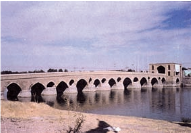
تصویر شماره ۱۹-۴ - پل شهرستان بر روی رودخانه زاینده رود مربوط به دوره سلجوقی
