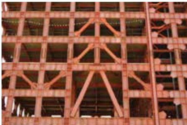
شکل ۱-۱- ساختمان با سازه اسکلت فولادی
