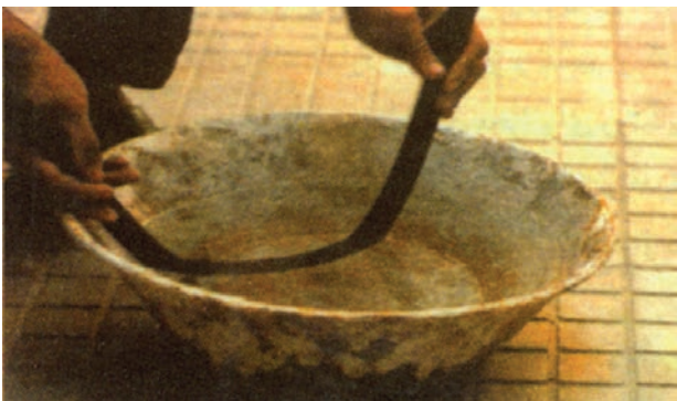
شکل ۴-۴۵- سرد کردن لوله پس از خم کاری
