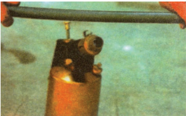
شکل ۴-۴۳- حرارت دادن لوله ی PVC
