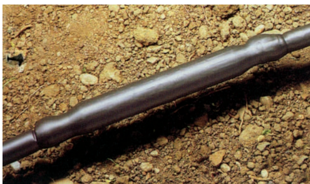
ج- وضعیت روکش پس از عملیات
