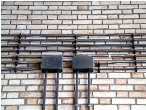
شکل ۵-۵۷- کابل‌کشی روی دیوار
