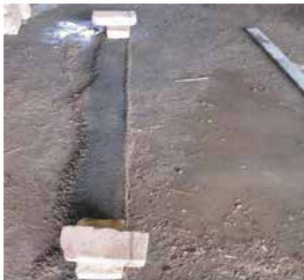
شکل ۱- ۷۳: بادخور نمودن ریسمان کار
