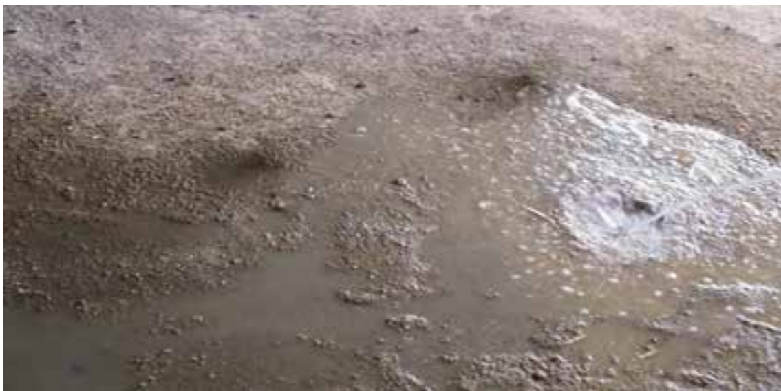
شکل ۱-۶۷: خیس کردن سطح زیر کار
