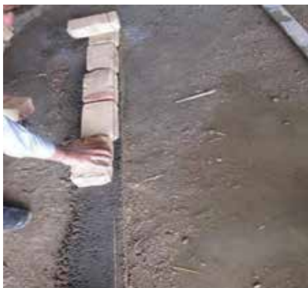
شکل ۱- ۷۴: نحوه چیدن آجر در امتداد ریسمان کار
