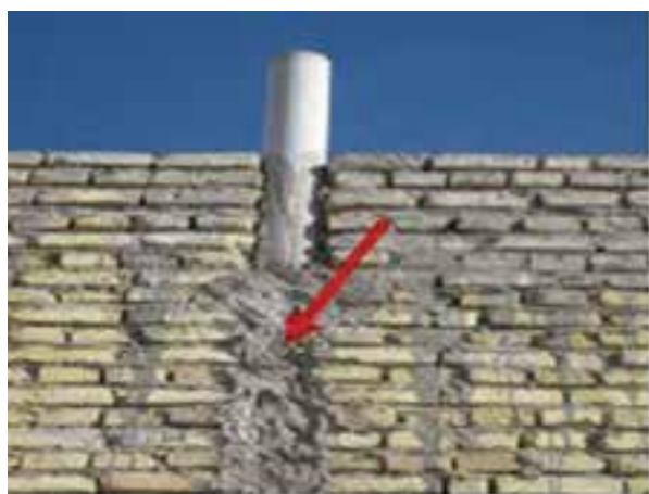
شکل ۱ - ۶۵: پر کردن درز لوله‌ها
