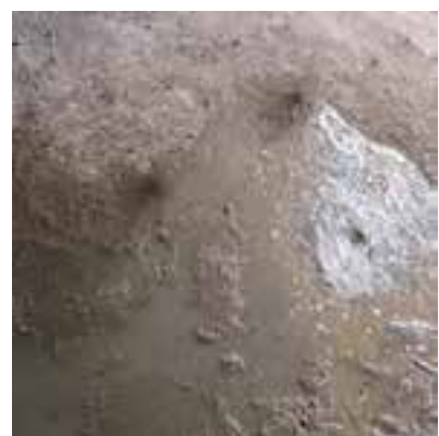
شکل ۱-۱۰۳: خیس کردن سطح زیر کار
