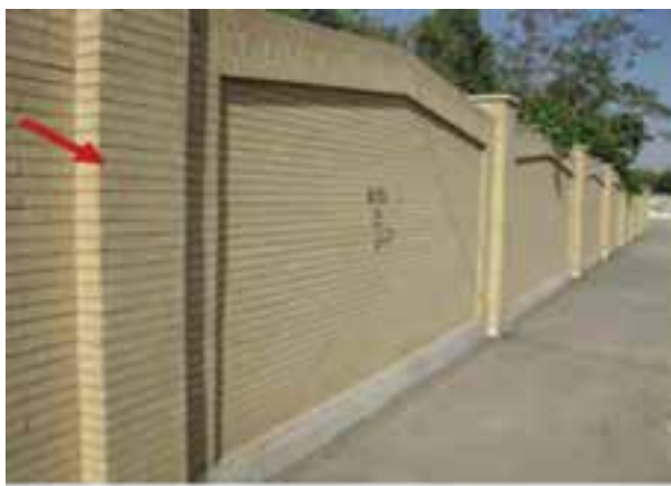
شکل ۱ - ۵۸ : وابند در دیوار حصارکشی
