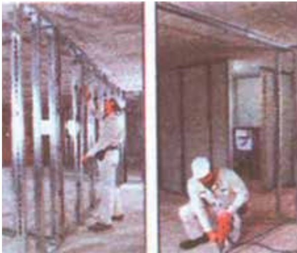
شکل ۱-۴۴ : قاب سازی جهت اتصال روکش های گچی
