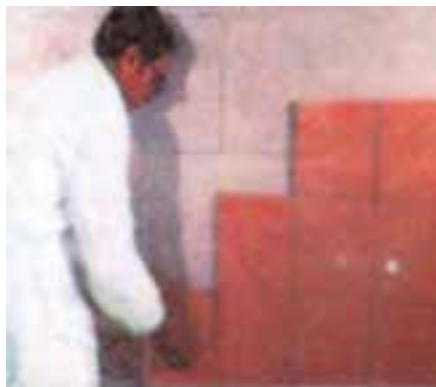
شکل ۱ - ۴۳: نصب کاشی روی قطعات پیش ساخته گچی
