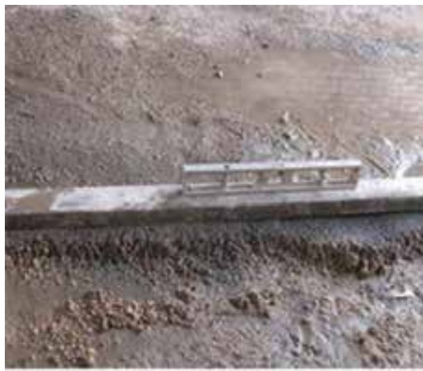
شکل ۱- ۶۹: تراز کردن روی ملات
