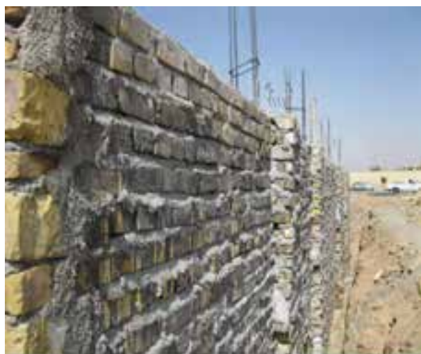
شکل ۱ - ۲۶: دیوار آجری با کلاف بندی قائم
