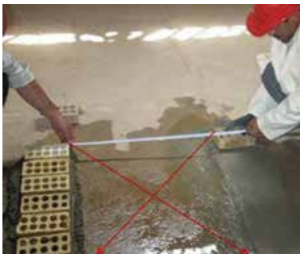
شکل ۱ - ۳۳ (ب): جدا کردن اندازه دو طرف دیگر
