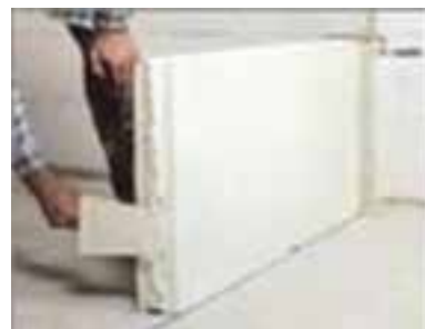
شکل ۱ - ۳۶: طریقه نصب بلوک های گچی
