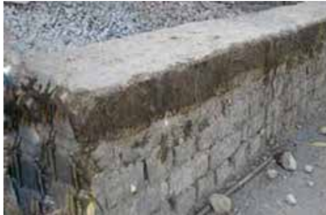
شکل ۱- ۲۹: کرسی چینی یا عایق کاری رطوبتی
