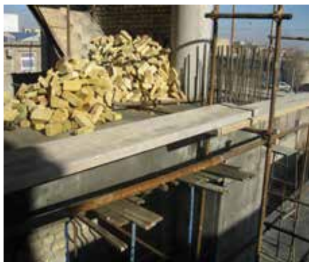
شکل ۱-۲: ضخامت مناسب برای تخته زیر پای
