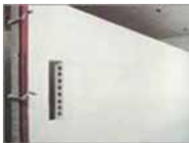
شکل ۱ - ۳۷: دیوار جداکننده با قطعات پیش ساخته گچی
