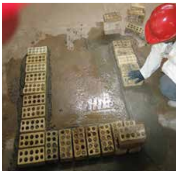
شکل ۱ - ۳۳ (ج): ریسمان کشی و چیدن ضلع سوم
