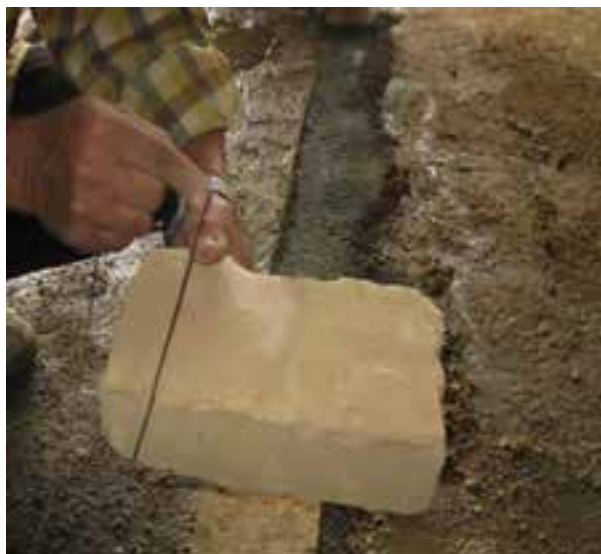
شکل ۱- ۷۲: نحوه بستن ریسمان کار به آجر
