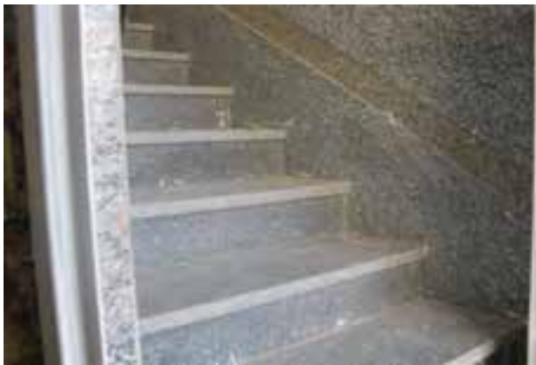
شکل ۱-۱۶ : کاربرد سنگ در نمای ساختمان
