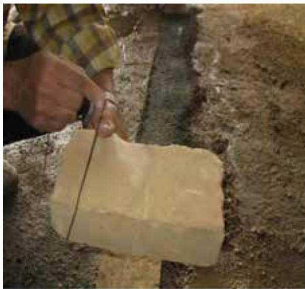
شکل ۱- ۸۹: نحوه بستن ریسمان کار به آجر
