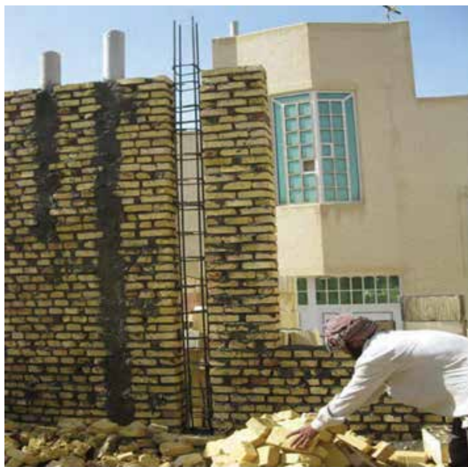
شکل ۱ - ۶۰: اتصال کلاف قائم و افقی در دیوار
