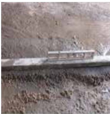
شکل ۱-۱۰۵: تراز کردن روی ملات
