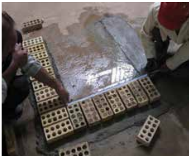
شکل ۱ - ۳۳ (الف): برداشتن طول دیوار
