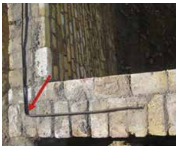
شکل ۱ - ۵۵: میلگرد گذاری در محل اتصال دو دیوار
