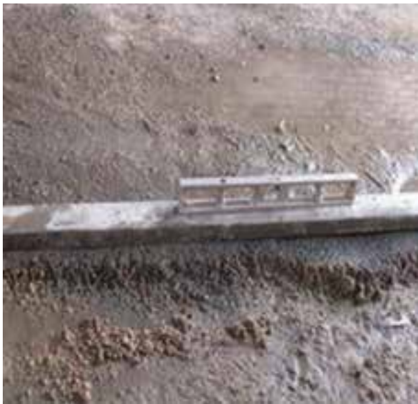
شکل ۱ - ۸۶: کنترل تراز سطح ملات
