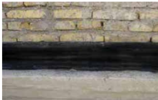
شکل ۱- ۳۰: دیوار روی کرسی چینی
