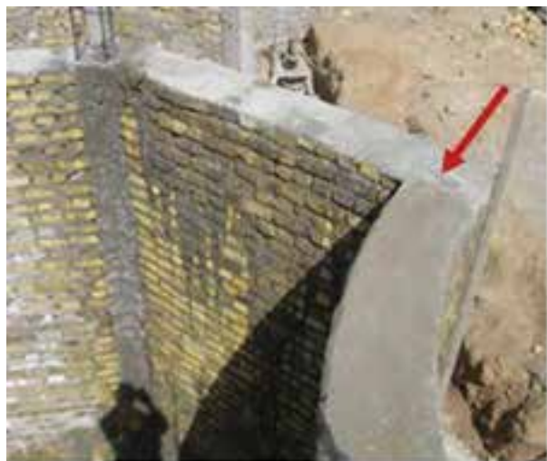
شکل ۱ - ۵۴: دیوار در زاویه
