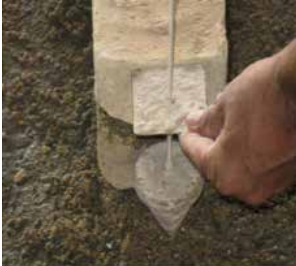
شکل ۱- ۷۷: شاقول کردن نبش کار
