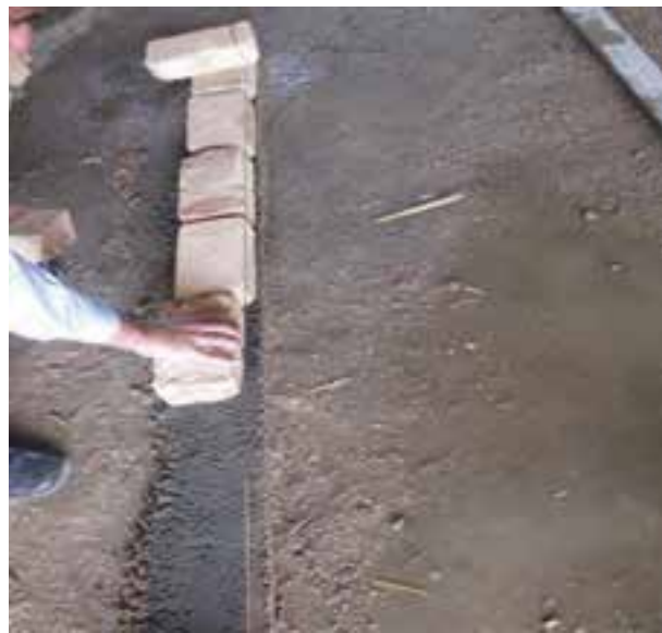
شکل ۱-۹۱: نحوه چیدن آجر در امتداد ریسمان کار
