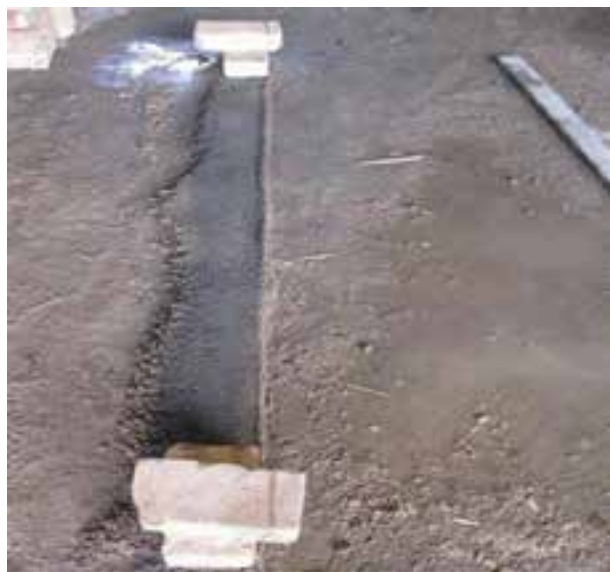
شکل ۱- ۹۰: بادخور نمودن ریسمان کار
