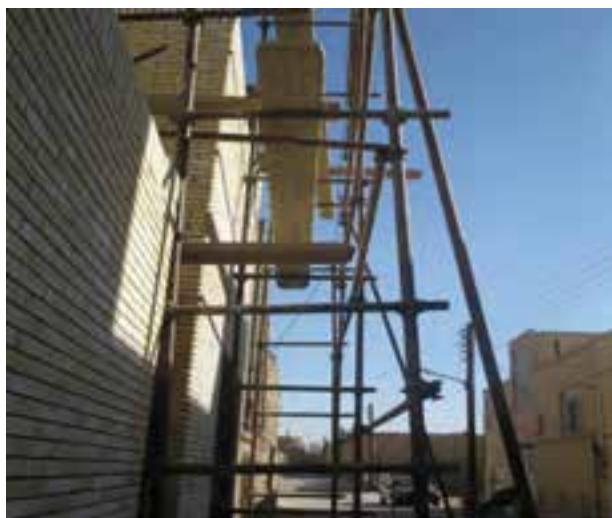
شکل ۱-۱: داربست فلزی برای چیدن دیوار
