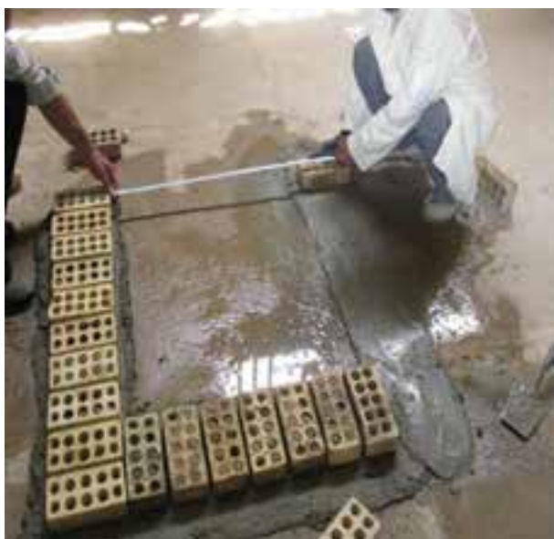
شکل ۱ - ۳۳ (ب): جدا کردن اندازه دو طرف دیگر
