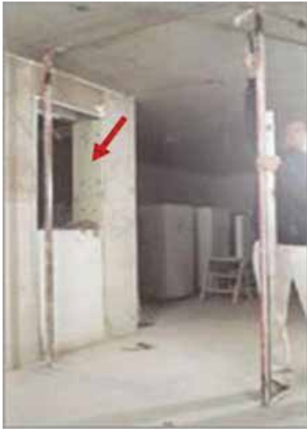
شکل ۱ - ۴۱: محل نصب پنجره در قطعات پیش ساخته گچی
