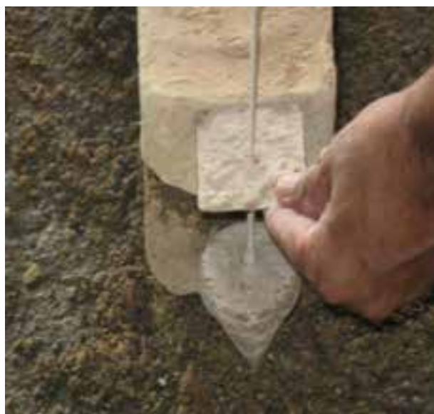
شکل ۱-۹۴: شاقول کردن نبش کار
