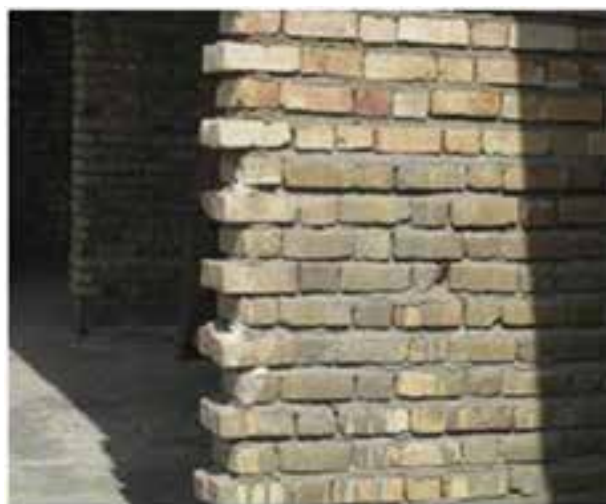
شکل ۱-۵۲: لابند در دیوار آجری
