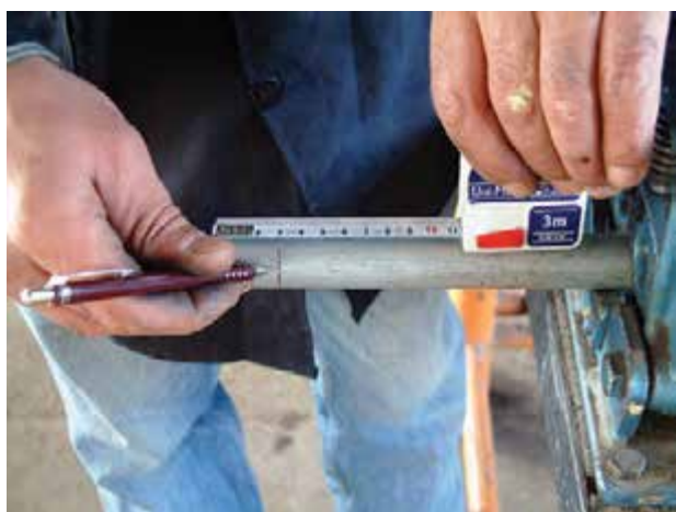
شکل ۱-۷- علامت‌گذاری کردن لوله با متر و مداد
