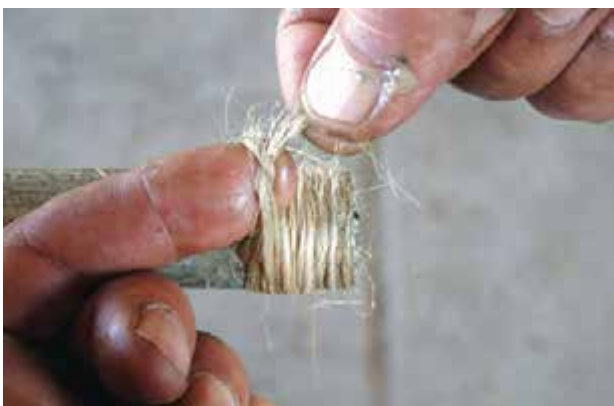
شکل ۵-۵۵- گره زدن انتهای پیچیدن کنف
