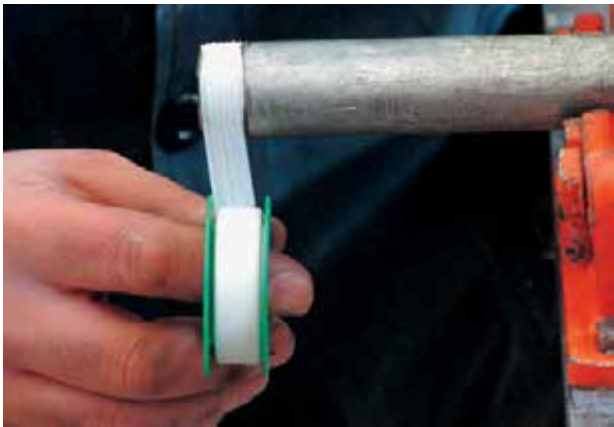
شکل ۵-۵۸- نحوه‌ی پیچیدن نوار تفلون بر روی سردنده
