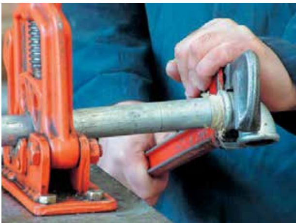
شکل ۹۲-۵- سفت کردن فیتینگ به وسیله‌ی آچار لوله‌گیر
