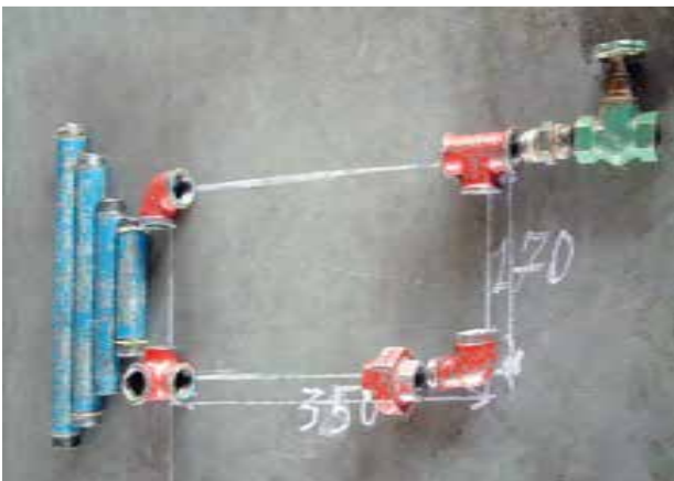
شکل ۵-۱۱۳- بریدن و حدیده کردن لوله‌ها
