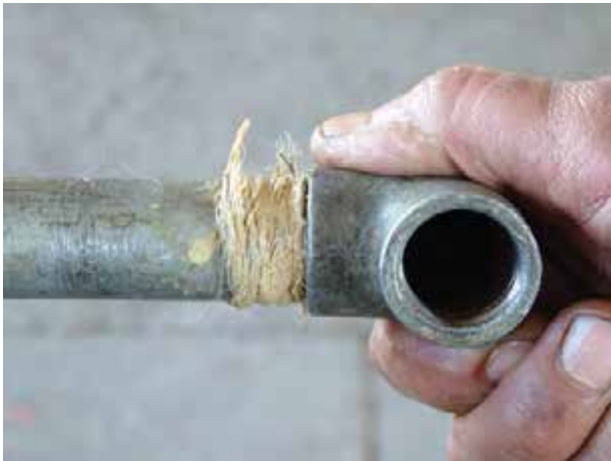
شکل ۹۱-۵- بستن فیتینگ بر روی سردنده
