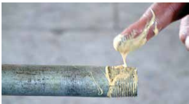
شکل ۵-۵۳- مالیدن خمیر بر روی سردنده
