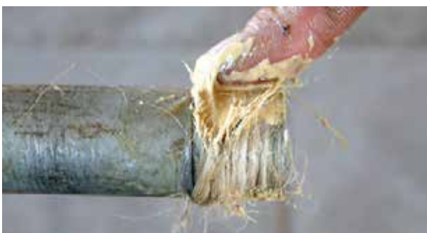
شکل ۵-۵۷- مالیدن خمیر آب بندی بر روی کنف
