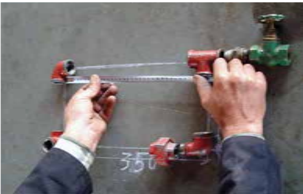
شکل ۵-۱۱۲- اندازه‌گیری طول لوله
