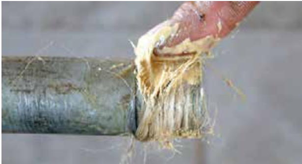
شکل ۵-۱۰۰- استفاده از مواد آب‌بندی
