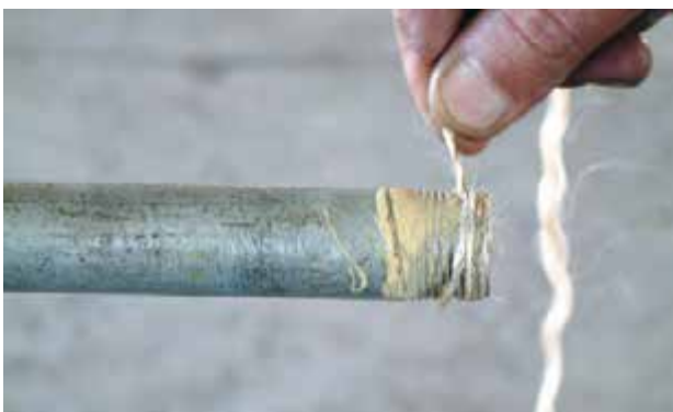
شکل ۵-۵۴- پیچیدن کنف بر روی سردنده
