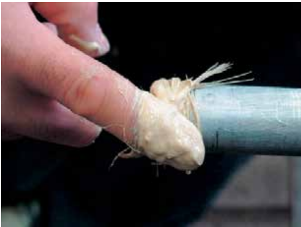
شکل ۹۰-۵- خمیر و کنف کردن سردنده
