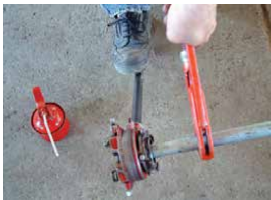
شکل ۱۲۰-۵- عمل حدیده کاری لوله
