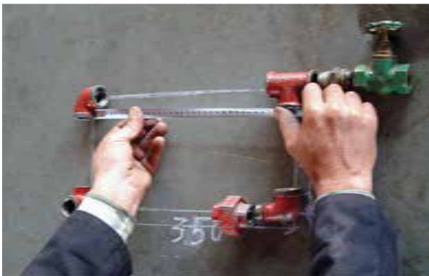
شکل ۱۴۹-۵- اندازه گیری طول لوله ها
