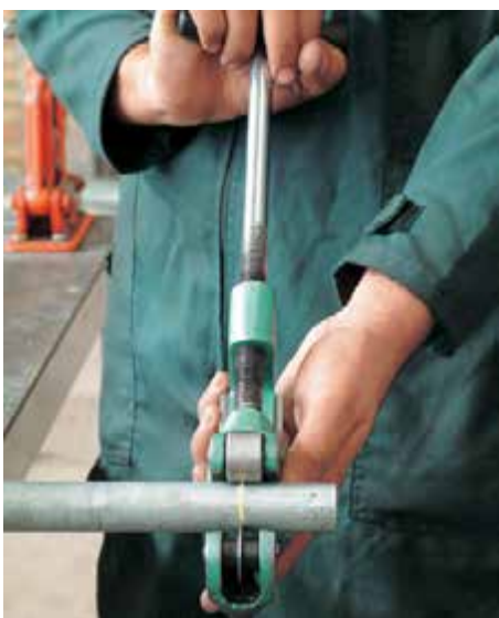
شکل ۱۳۵-۵- بریدن لوله‌های مورد نیاز
