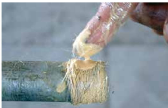
شکل ۱۵۲-۵- خمیر و کنف کردن سردنده‌ها
