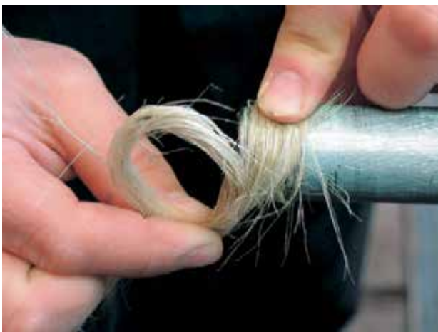
شکل ۱۳۸-۵- پیچیدن مواد آب‌بندی به سردنده‌ها
