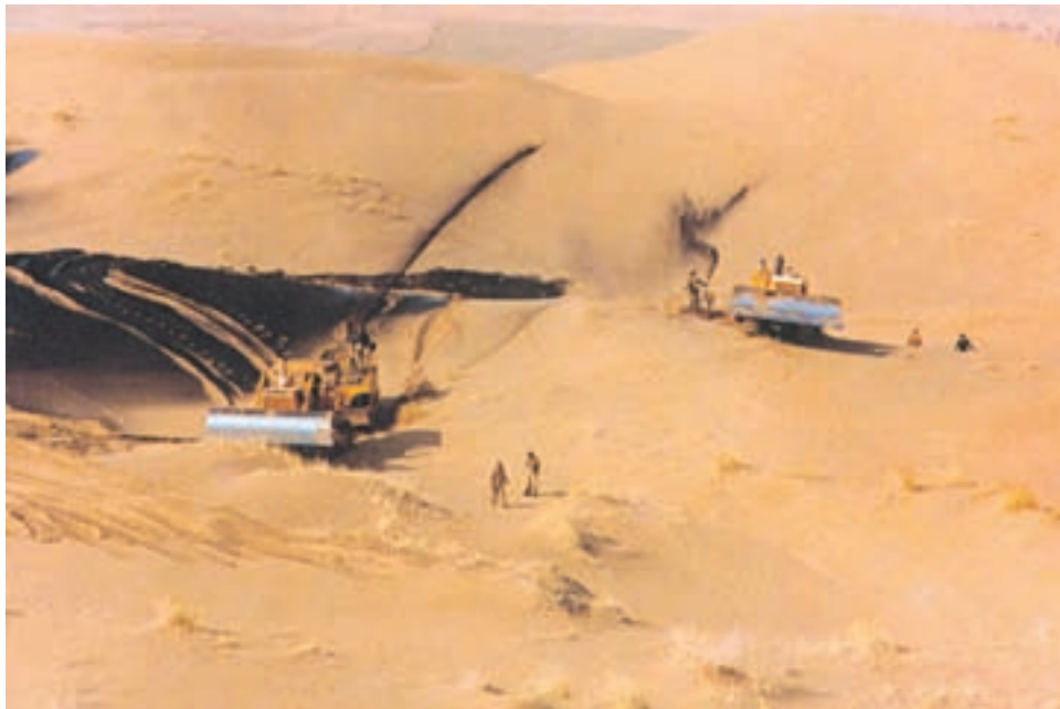
شکل ۱۱-۳- پاشیدن مالچ نفتی بر روی ماسه های روان
