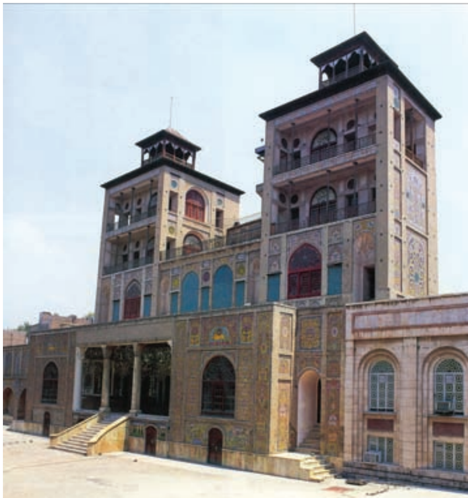
ساختمان شمس‌العماره در تهران
