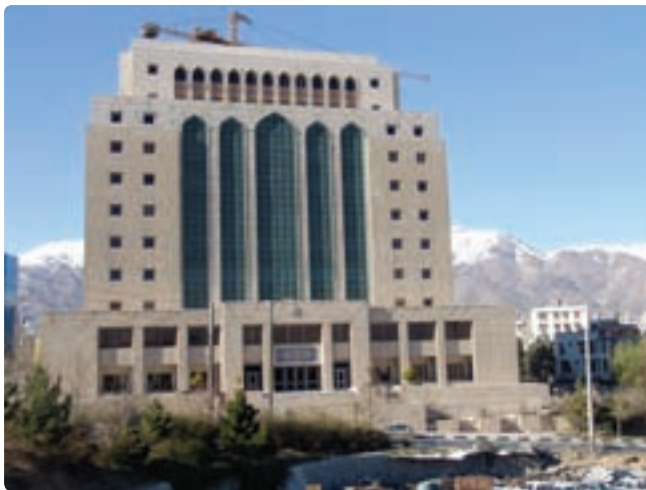
ساختمان گنجینه اسناد ملی
