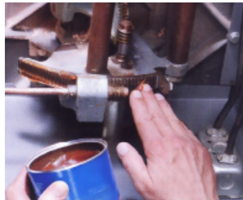
شکل ۱۲-۳۴- گریس‌کاری پرغ دنده‌ها.
