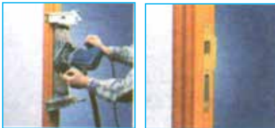
شکل ۱۶-۳۰- ایجاد شیار ممل استقرار برگی روی جای زبانه قفل.
