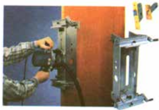
شکل ۱۶-۲۸- شیار زدن جای مغزی قفل با استفاده از شابلن.
