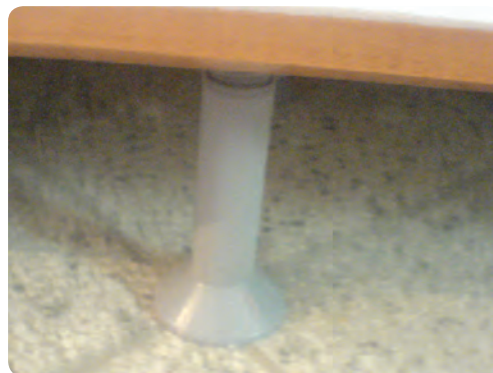
شکل ۶-۶۴ پایه نصب شده در زیر کابینت
