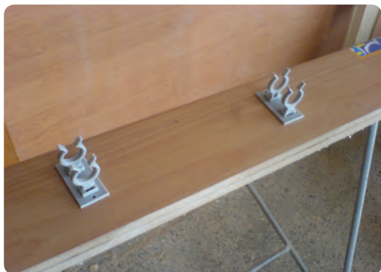
شکل ۶-۶۵ اتصال کلیس پاسنگ به پایه کابینت
