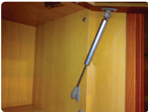
شکل ۶-۳۶ در کابینت با درجه یا نگه‌دارنده پمپی
