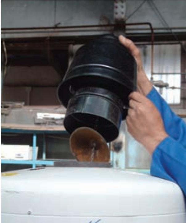
شکل ۱-۱۱۵- برداشتن کلاهک تعدیل از روی دودکش
