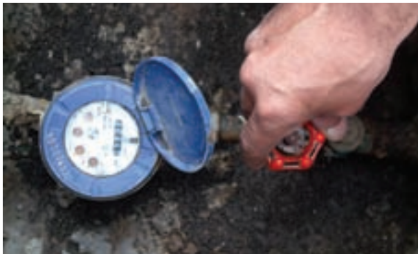
شکل ۱-۲۰۹ - بستن شیر فلکه‌ی اصلی ساختمان
