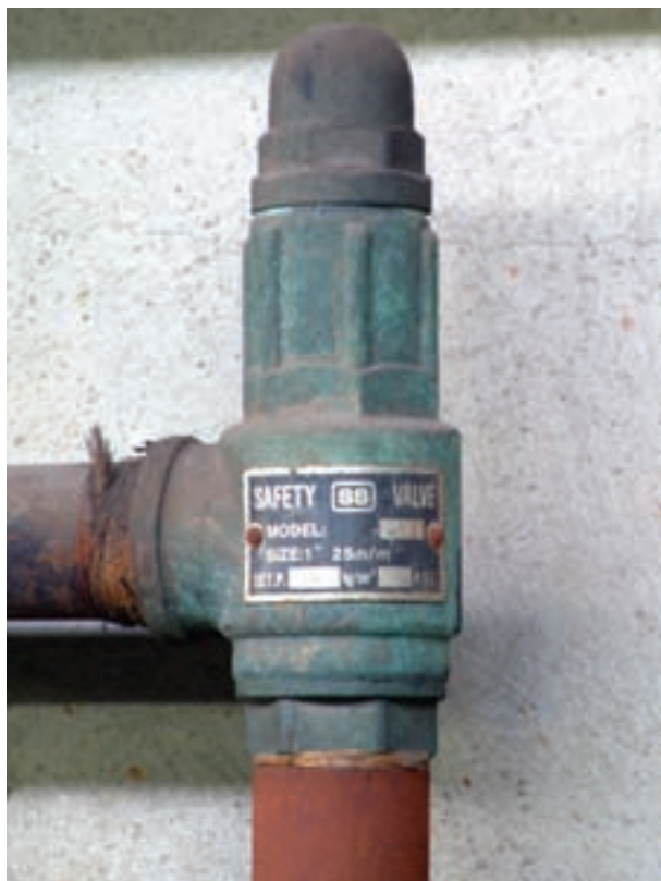
شکل ۲-۱۰۶- شیر اطمینان حساس در برابر فشار
