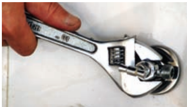
شکل ۱۴۴-۲- سفت کردن شیر پیسوار با آچار فرانسه
