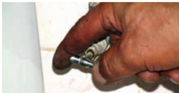
شکل ۱۴۶-۲- عمل هواگیری
