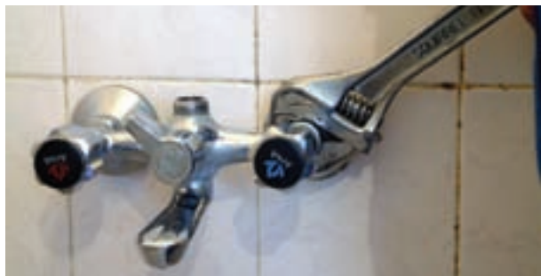
شکل ۲-۲۰۶- سفت کردن مهره‌های شیر با آچار
