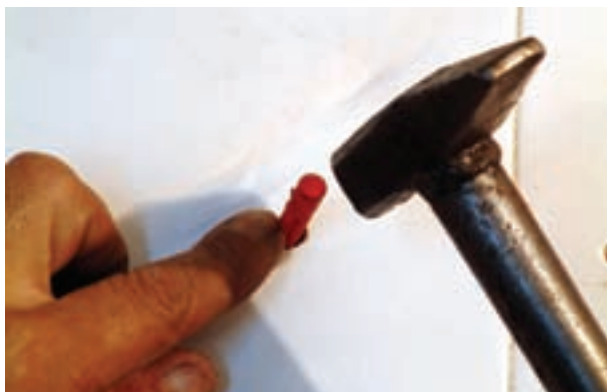
شکل ۱۹۳-۲- کوبیدن رولپلاک درون سوراخ
