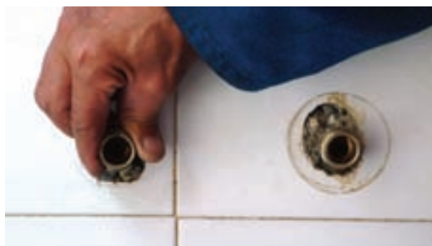
شکل ۲-۱۸۴- بیچیدن دنباله‌ها به محل نصب شیر
