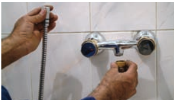
شکل ۱۹۱-۲- اتصال شیلنگ آفتابه به شیر مخلوط توالت
