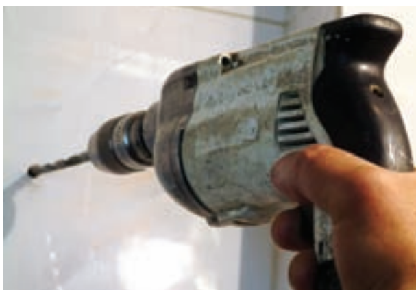
شکل ۱۹۲-۲- سوراخ کردن محل نصب بست آویز
