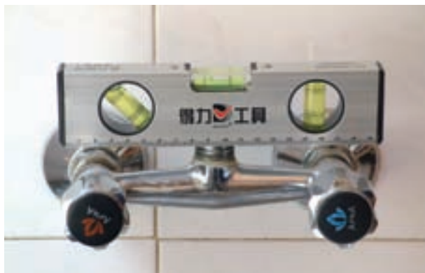
شکل ۱۷۴-۲- سنجش تراز بودن شیرمخلوط دیواری
