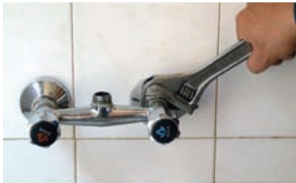
شکل ۱۷۳-۲- سفت کردن مهره‌ها به وسیله‌ی آچارفرانسه
