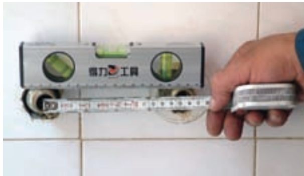
شکل ۲-۱۸۶- کنترل صاف بودن و اندازه‌ی دنباله‌ها
