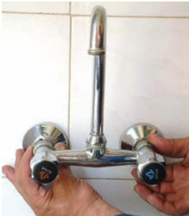
شکل ۱۷۲-۲- پیچیدن مهره‌ها به دنباله‌های شیر مخلوط
