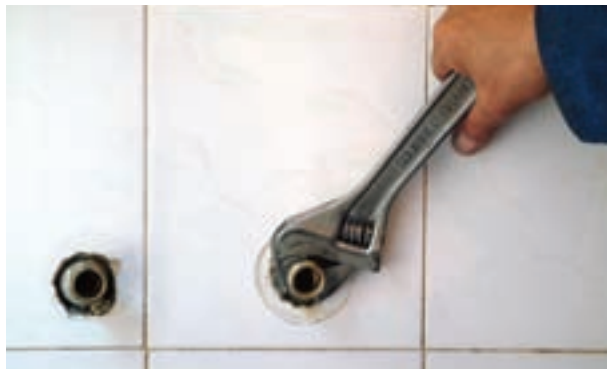
شکل ۲-۲۰۱- سفت کردن دنباله‌ها با آچار
