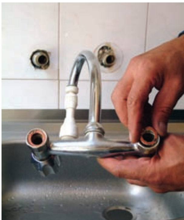
شکل ۲-۱۷۱- قراردادن واشر درون مهره‌ی تنه شیرمخلوط
