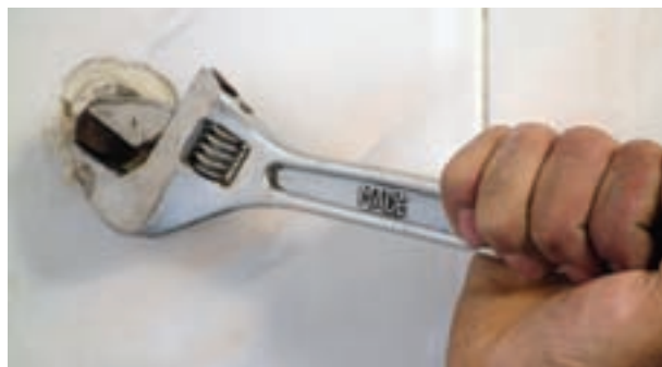
شکل ۲-۱۸۲- بازکردن درپوش‌ها
