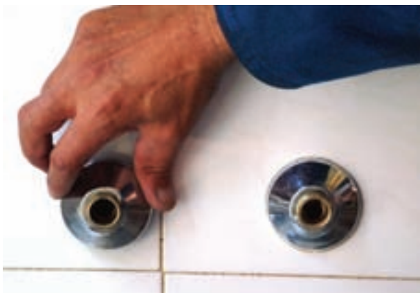
شکل ۲-۱۷۰- بستن کاسه‌ها به دنباله‌ها با دست
