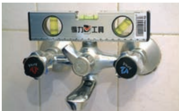
شکل ۲-۲۰۷- سنجش تراز بودن شیر مخلوط دوش
