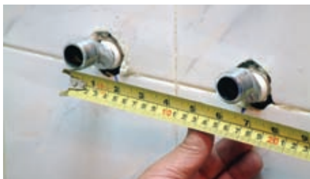
شکل ۱۶۸-۲ کنترل اندازه‌ی محور تا محور دنباله‌ها
