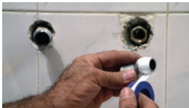
شکل ۲-۱۸۳- بیچیدن نوار تفلون به دنباله‌ها
