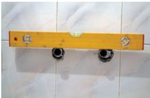
شکل ۲-۱۶۹- کنترل صاف بودن دنباله‌ها
