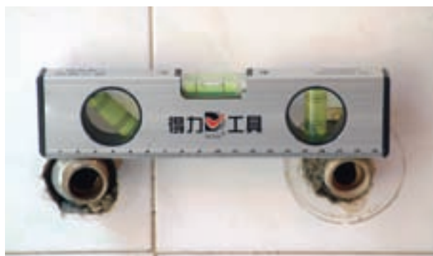
شکل ۲-۲۰۳- کنترل تراز بودن دنباله‌ها
