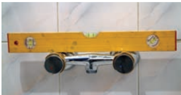
شکل ۱۹۰-۲- سنجش تراز بودن شیر مخلوط
