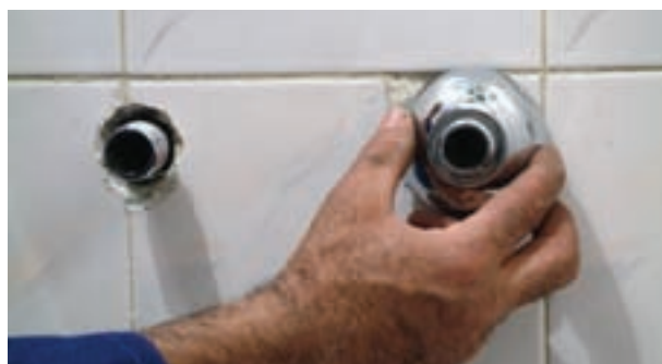
شکل ۲-۲۰۴- پیچیدن کاسه‌ها به دنباله‌ها
