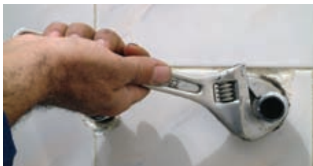
شکل ۱۶۷-۲ سفت کردن دنباله‌ها با آچار فرانسه
