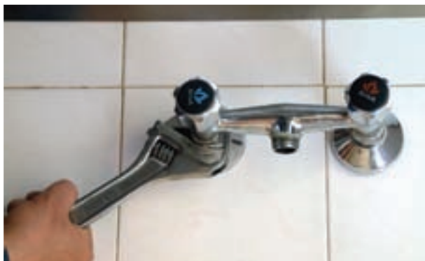
شکل ۱۸۹-۲- سفت کردن مهره‌ها با آچار فرانسه
