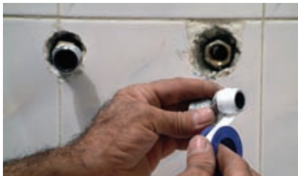
شکل ۱۹۹-۲- پیچیدن نوار تفلون به دور دنده‌ی ۱/۴ دنباله‌ی شیر مخلوط
