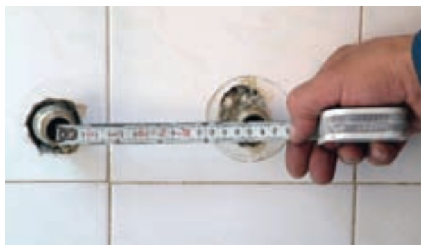
شکل ۲-۲۰۲- کنترل نمودن فاصله‌ی دنباله‌ها به وسیله‌ی متر
