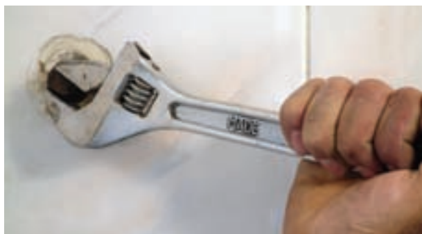
شکل ۱۹۸-۲- باز کردن درپوش‌ها
