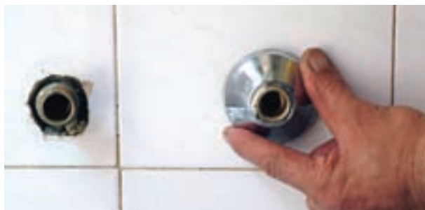
شکل ۲-۱۸۷- اتصال کاسه‌ها به دنباله‌ها
