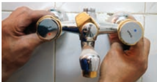
شکل ۲-۲۰۵- بستن مهره‌های شیر مخلوط دوش با دست
