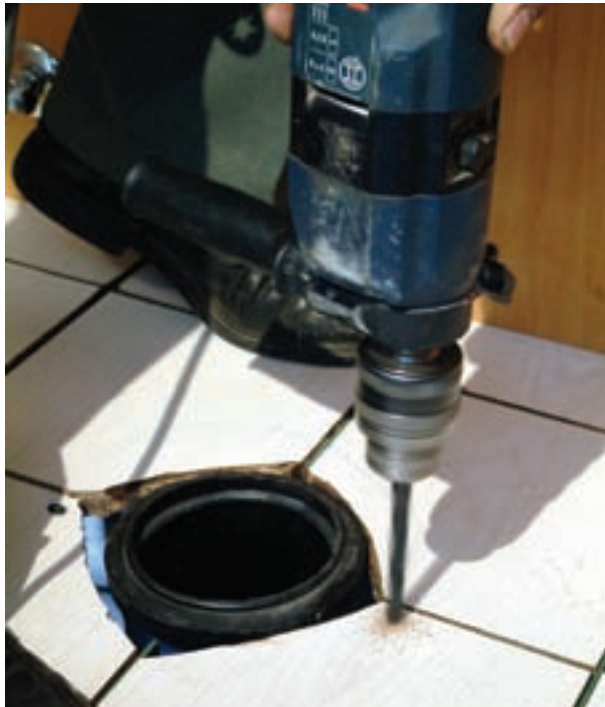
شکل ۲۴۶-۳- سوراخ‌کاری محل‌های علامت‌گذاری شده
