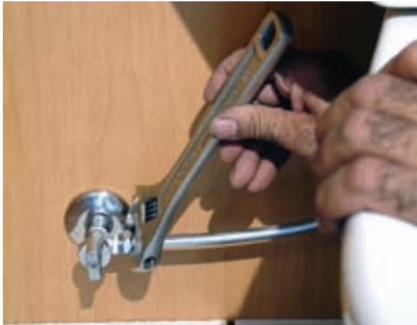
شکل ۳-۲۵۶- سفت کردن مهره‌ی شیر پیسوار
