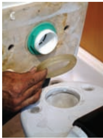
الف - قبل از قرار دادن لاستیک رابط بر روی مهره‌ی اتصال پمپ تخلیه ب - بعد از قرار دادن لاستیک رابط بر روی مهره‌ی اتصال پمپ تخلیه
