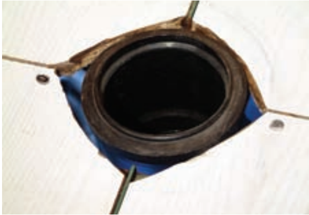
شکل ۲۴۴-۳- قرار دادن بوگیر در داخل زانویی
