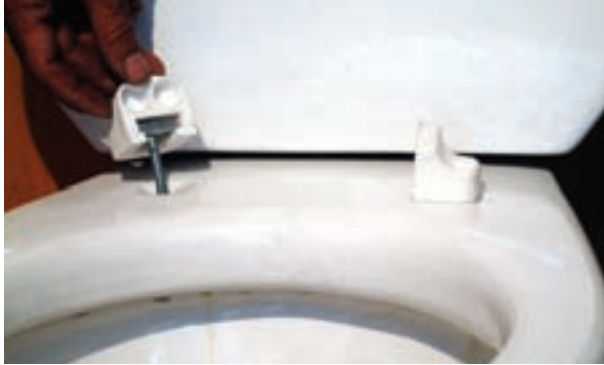
شکل ۳-۲۵۳- اتصال بست‌های نگهدارنده به توالت فرنگی
