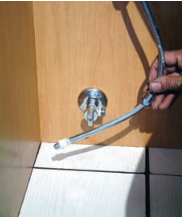
شکل ۳-۲۵۵- خمکاری لوله‌ی پیسوار
