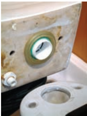
الف - قبل از قرار دادن لاستیک رابط بر روی مهره‌ی اتصال پمپ تخلیه ب - بعد از قرار دادن لاستیک رابط بر روی مهره‌ی اتصال پمپ تخلیه
