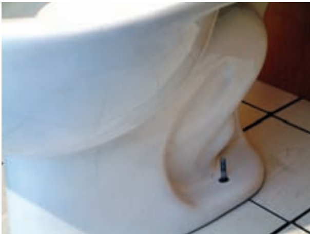
شکل ۲۴۸-۳- قرار دادن توالت فرنگی در محل خود
