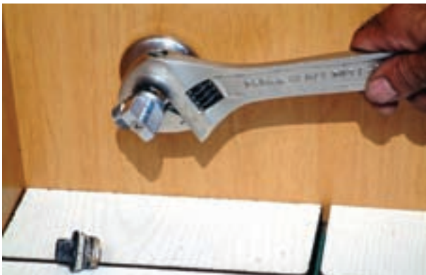
شکل ۳-۲۵۴- سفت کردن شیر پیسوار
