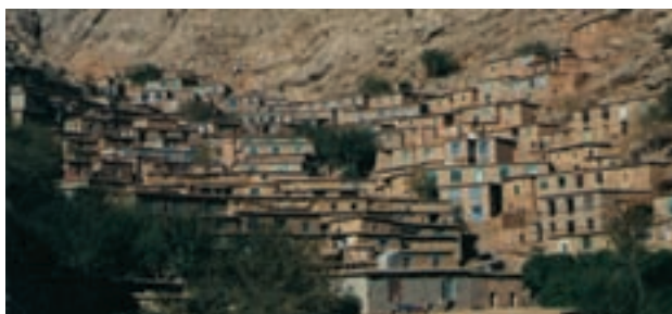
شکل ۴۰-۲- روستای پلکانی هجیج در منطقه‌ی پاوه‌ی کرمانشاه
