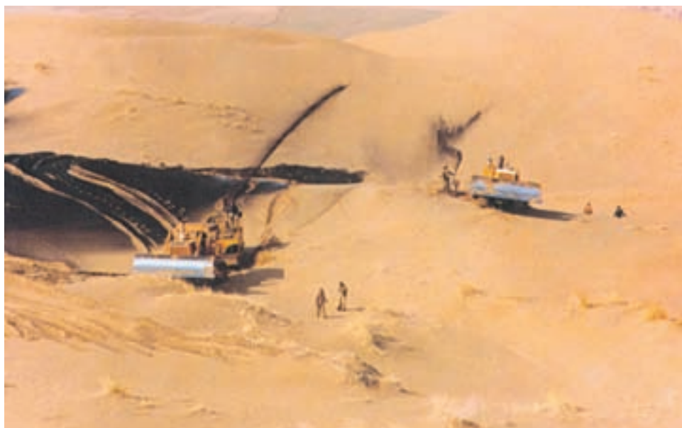
شکل ۹-۳- پاشیدن مالچ نفتی بر روی ماسه‌های روان
