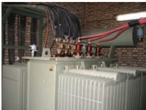
ب) ترانسفورماتور بدون جعبه ترمینال
