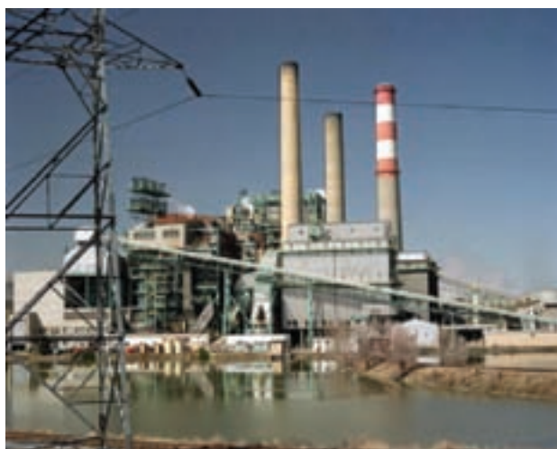
شکل ۲- نمایی از یک نیروگاه گازی
