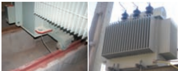
شکل ۳۷- محل اتصال سیم زمین
