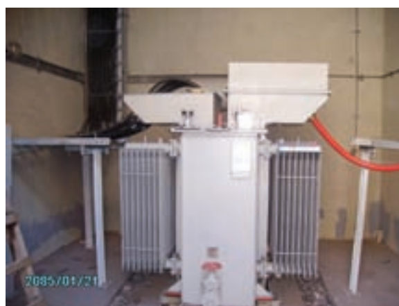
الف) ترانسفورماتور با جعبه ترمینال
