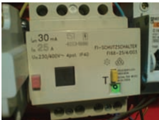
شکل ۱-۱۸- فیوز حفاظتی نصب شده در کارگاه
