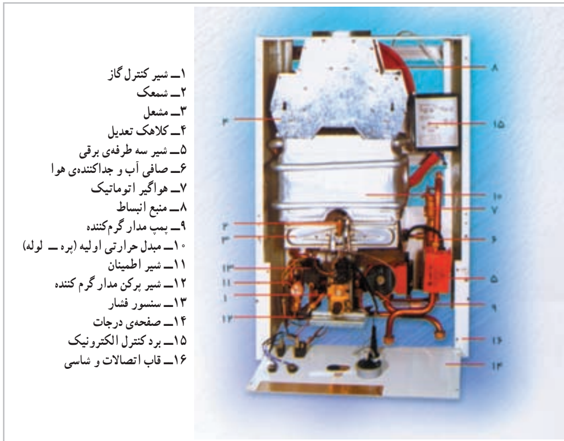
شکل ۷-۱۴- ساختمان و اجزای تشکیل دهنده‌ی شوفاز دیواری
