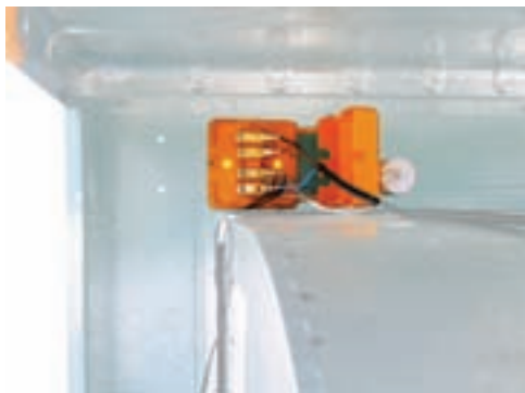
شکل ۱۲-۱۱- جعبه اتصال الکتریکی کولر
