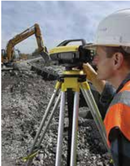
شکل ۱- ۱۴ - اجرای تسطیح و کنترل حین اجرا
