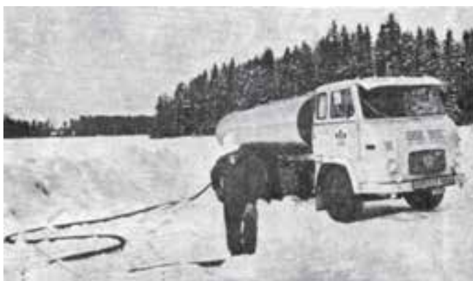
شکل ۱۵-۶- پمپاژ رثولیت به داخل چال
