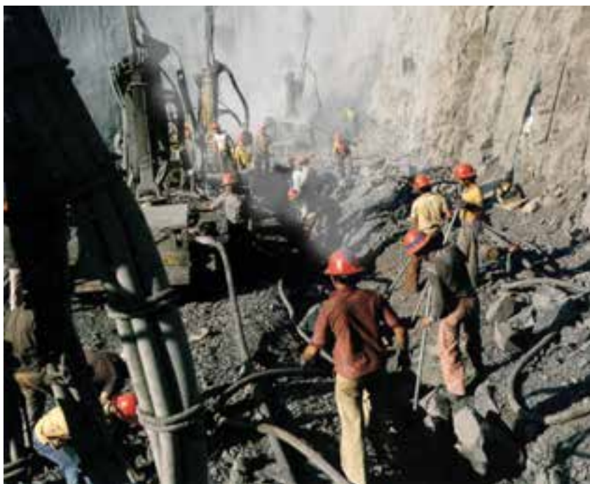
شکل ۲-۵۵- اثر جریان‌های مخالف در دیواره‌های پرشیب و آلودگی اتمسفر معدن
