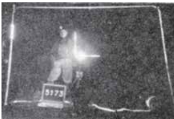
شکل ۲-۱۵- اندازه‌گیری مساحت مقطع به روش عکاسی
