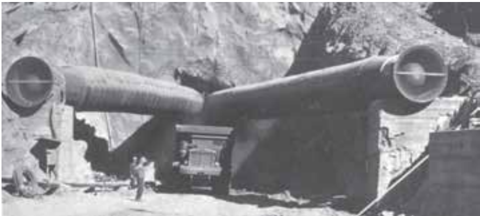
شکل ۳۷-۲- لوله‌های فلزی تهویه با اتصالات جوشکاری شده
