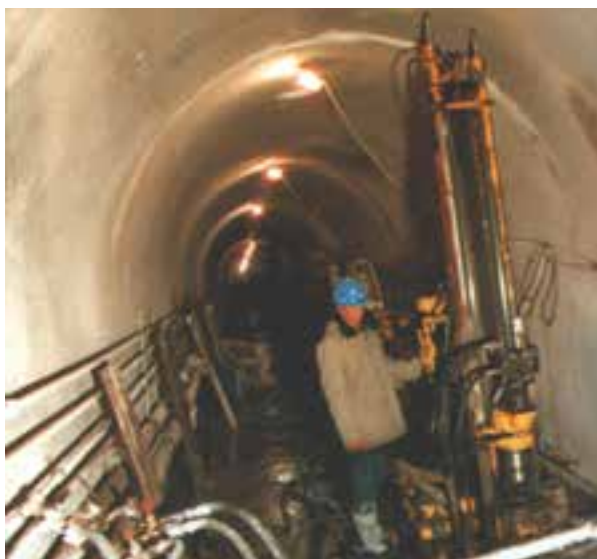
شکل ۹-۴- شکل عمومی یک تونل با چراغ‌های روشنایی قاب‌دار با لامپ رشته‌ای
