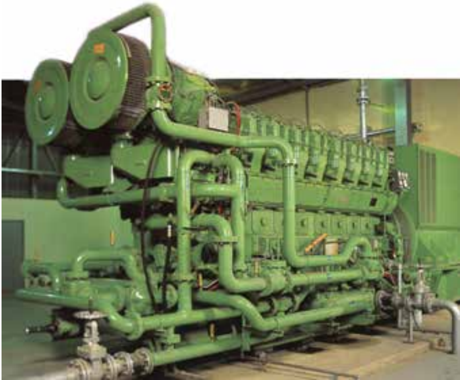
شکل ۲-۸- موتور ژنراتور یک نیروگاه برق اضطراری معدن
