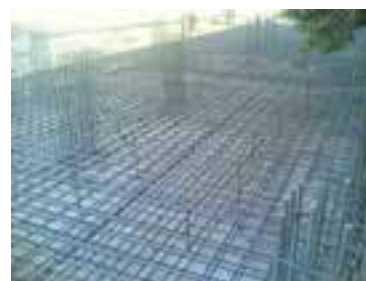
شکل ۱-۱۴ یکی از انواع کامپوزیت‌ها بتن مسلح است
