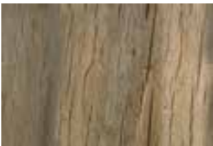
شکل ۱۴-۱- ترک های سطحی در تخته
