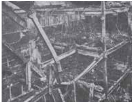
شکل ۲۶-۵-ب - سازه‌ای از تیر حمل فولادی که در آتش‌سوزی از بین رفته است (بریتانیای کبیر).
