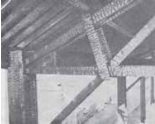
شکل ۲۶-۵-الف - این تیرهای چوبی در یک انبار نگهداری چوب آلات، پس از یک آتش‌سوزی شدید سالم ماندند چرا که لایه‌ی عایقی از زغال بر روی سطح آن ایجاد شده بود.
