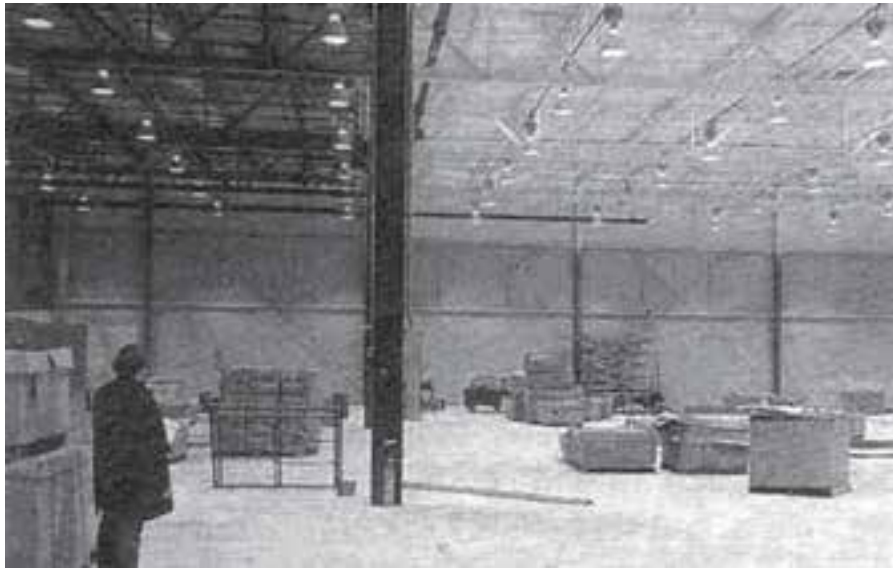
شکل ۲۴-۳- سیستم روشنایی عمومی
