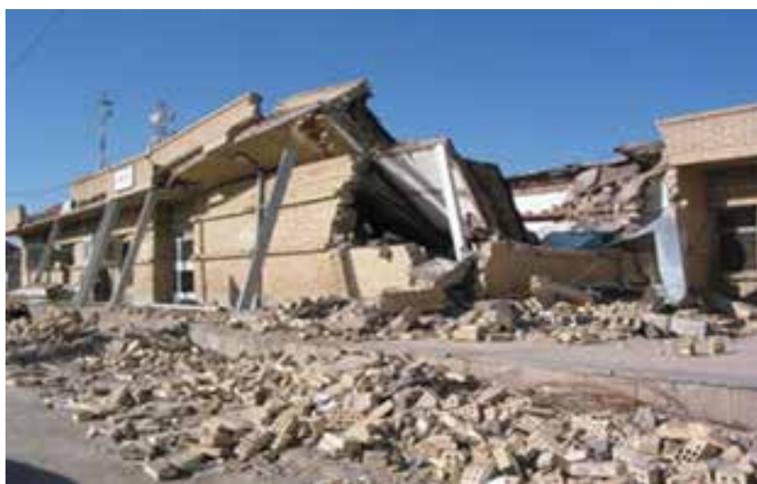
شکل ۱۲-۲- خسارات ناشی از زلزله در استان
