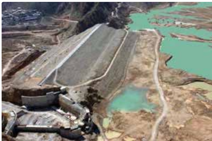
شکل ۱-۲۶- احداث سد سیوند بر روی رود سیوند
