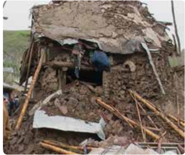
شکل ۲-۵- زلزله سال ۱۳۸۳- طالقان
