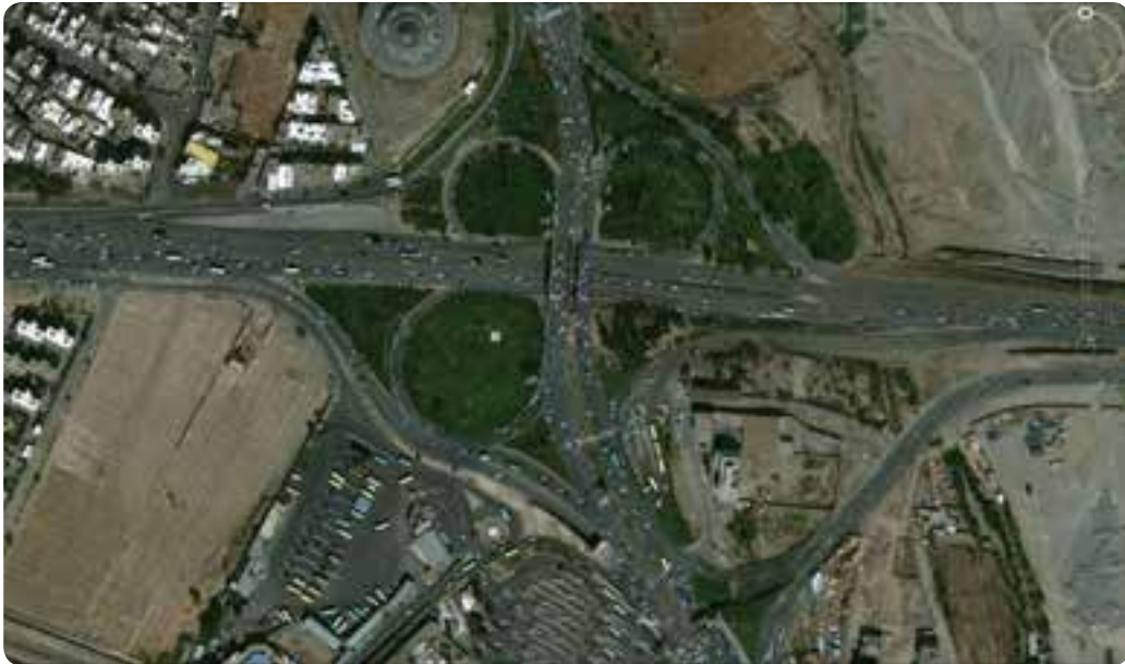
شکل ۱-۲- استان البرز پل ارتباطی غرب و شرق کشور
