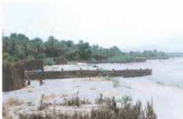
اپی‌های احداث شده با هدف حفاظت کناره‌ها
