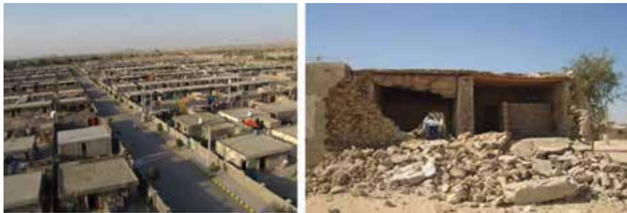
شکل ۵۴-۱- زلزله در شهرستان قشم
