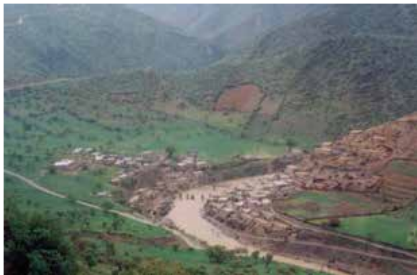
شکل ۳۸-۱- عدم رعایت حریم رودخانه و خطر سیل
