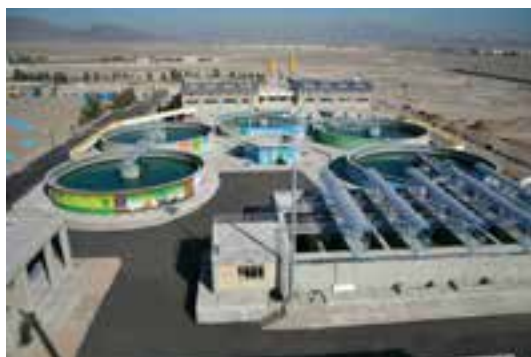
شکل ۱۲-۴- تصفیه خانه آب زاهدان
