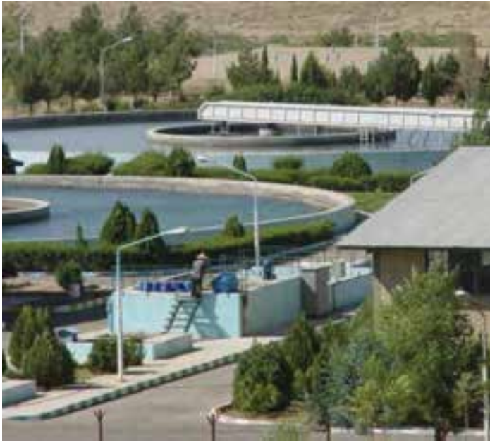
شکل ۳۲-۱- تصفیه‌خانه سد ۱۵ خرداد
